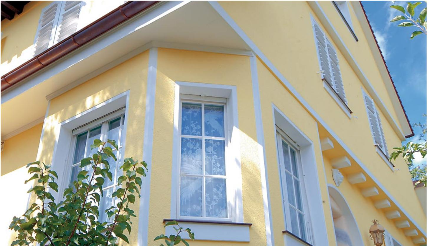
Wärmedämm-Verbundsysteme reduzieren nicht nur die Heizkosten im Winter, sondern minimieren auch die Aufheizung der Gebäudehülle im Sommer. Ohne WDVS können durchaus 32 °C im Innenraum entstehen. Mit WDVS sind dies an sehr heißen Tagen ca. 24 – 26 °C. Also **6 °C**, die den Wohnkomfort entscheidend beeinflussen. Auf eine anlagentechnische Klimatisierung kann gegebenenfalls verzichtet werden.
